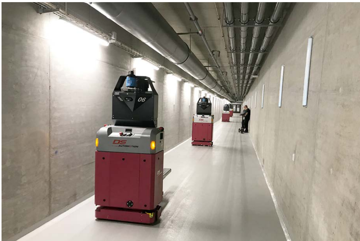
AGV'er i kælder
