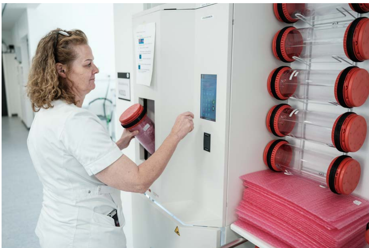
Anvendelse af rørpostsystem
